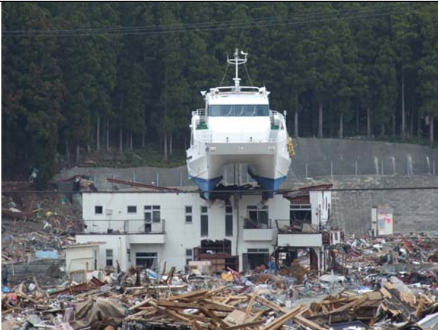
岩手県大槌町では観光船が2階建てビルの上に。
